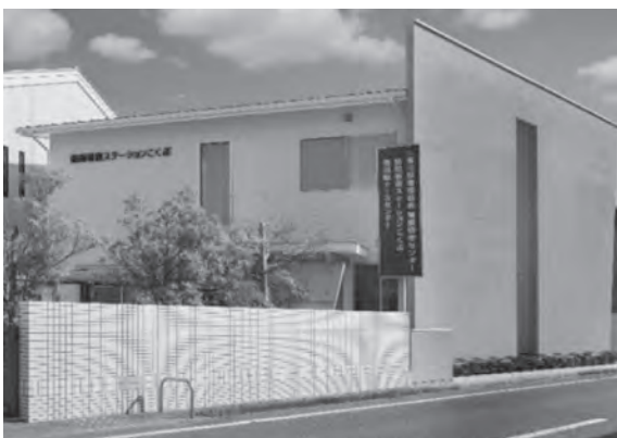
2021年3月に竣工した事務所
